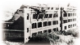
破壊された校舎
